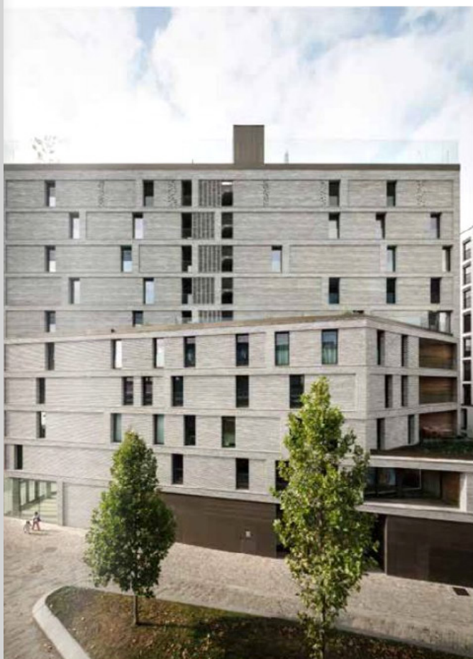
Het gelijkvloerse niveau is op een elegante manier uitgewerkt en zoekt aansluiting bij het aanpalende Engels Plein.
