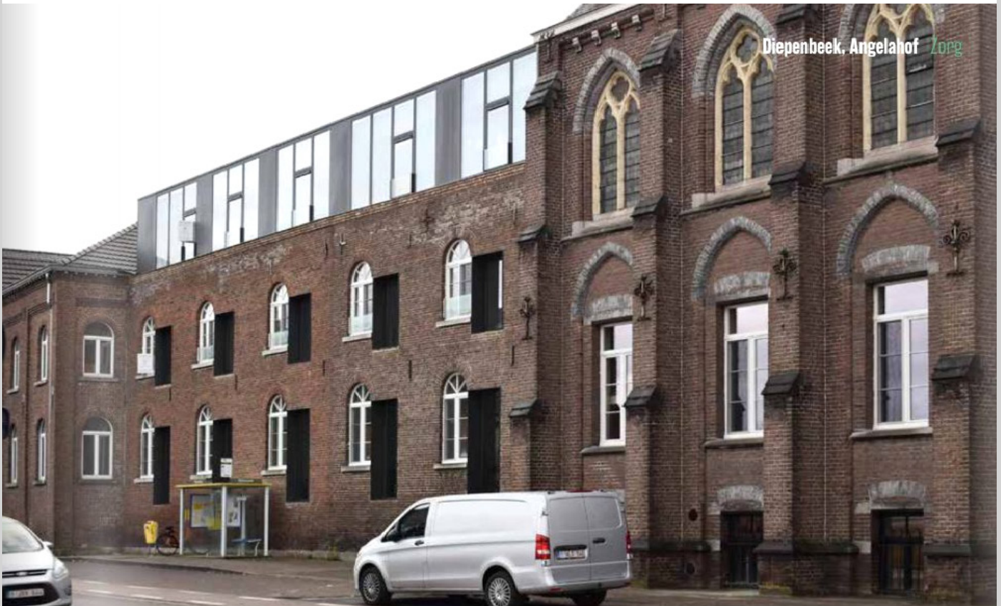
In bepaalde delen van het bestaande gebouw zijn nieuwe ramen toegevoegd om voldoende daglicht binnen te brengen.
